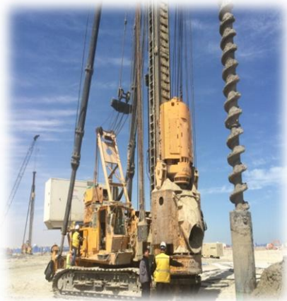
두바이 현장 (HED2160kW W)
